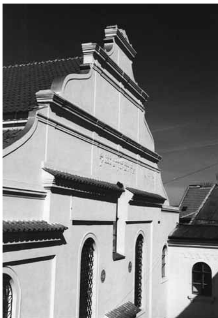
Průčelí synagogy je skryto za frontou domů, vstup je ze dvora bývalé židovské školy
